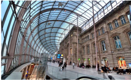
Gare de Strasbourg : intérieur de la verrière.
