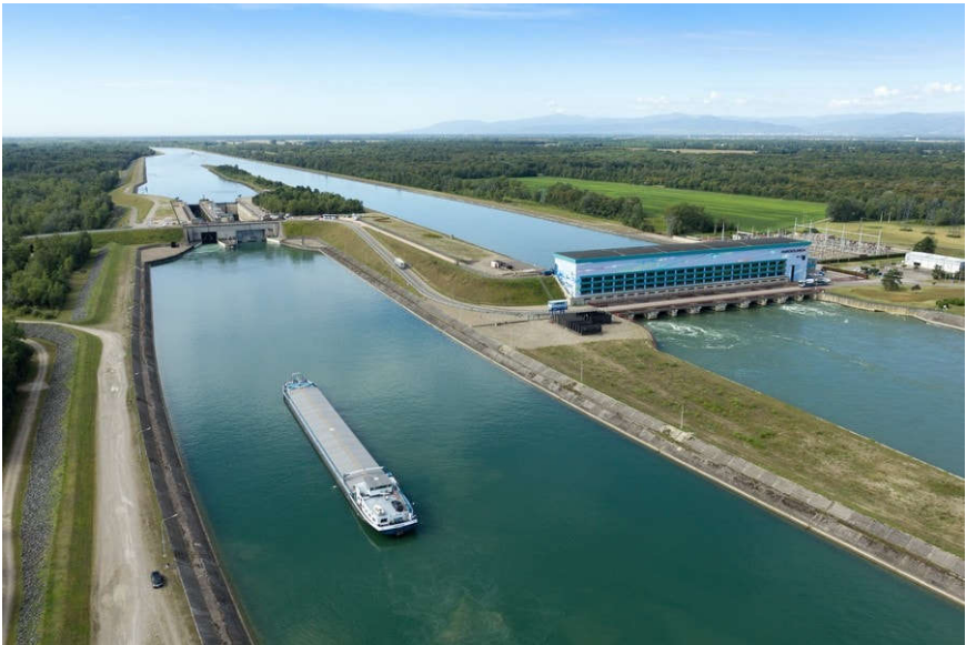
La centrale hydroélectrique installée sur le Grand Canal d'Alsace produit annuellement en moyenne près d'un milliard de kWh.
